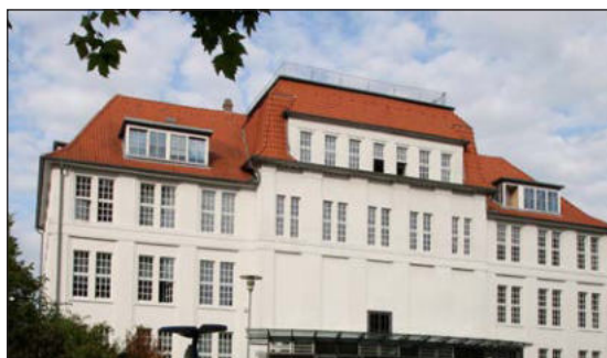
Abb. 128: Dachaufbau und Fenster im Dachgeschoss des Technikum
