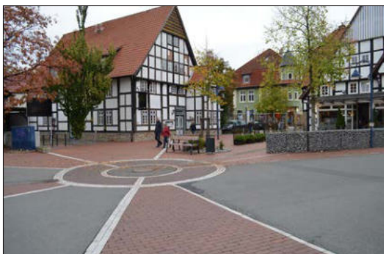
Abb. 94: Zustand und Aufteilung des Straßenraumes am Quartiersplatz Heidensche Straße
