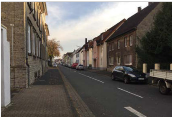
Abb. 40: Typische Bebauung in der „Stadterweiterung“ bis zum Bahnhof (Schulstraße)
