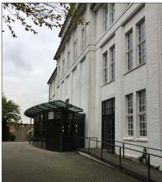
Abb. 127: Technikum Zugang Gartenseite
