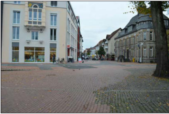
Abb. 73: Mangelhafter Zustand der Oberflächen und Ladenzonen um den Marktplatz
