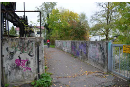
Abb. 108: Querung Wehr an der Mühle Altrogge
