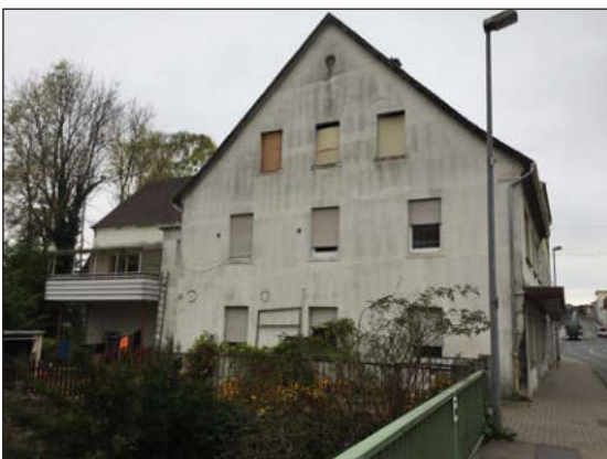
Abb. 125: Aufwertung des Straßen- und Gebäudebildes am Stadteingang West
