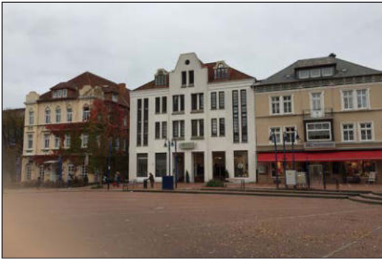
Abb. 38: Typische Bebauung im Innenstadtbereich/ Zentralen Versorgungsbereich (Marktplatz)
