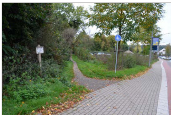
Abb. 105: Schlecht erkennbarer, mangelhafter zweiter Zugang zum Gelände Alte Burg von der Friedrich-Petri-Straße aus
