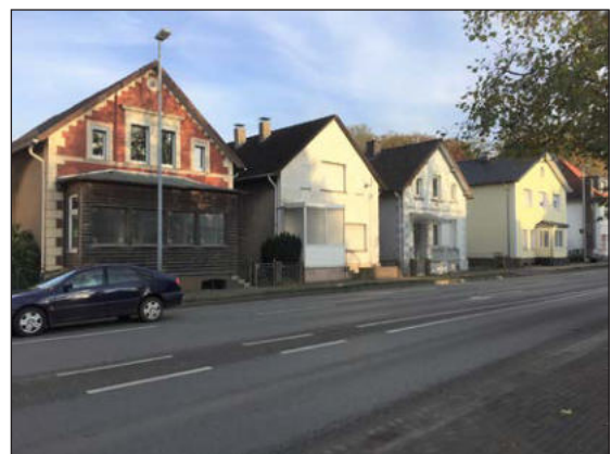
Abb. 44: Leerstehende mindergenutzte Gebäude an der Schötmarschen Straße / B 66
