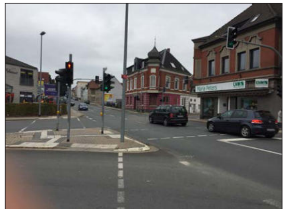
Abb. 43: Leerstehende Gebäude am Stadteingang West
