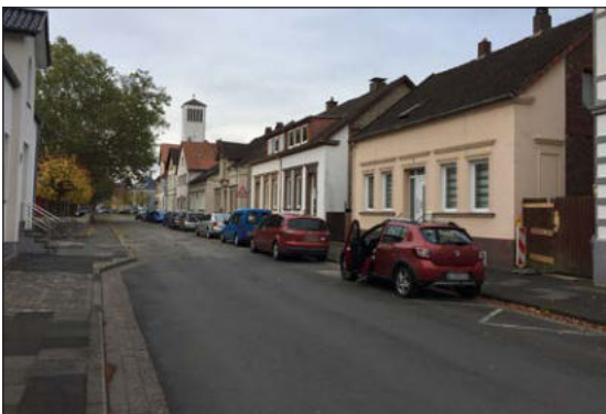
Abb. 41: Typische Bebauung in der „Stadterweiterung“ bis zum Bahnhof (Schulstraße)
