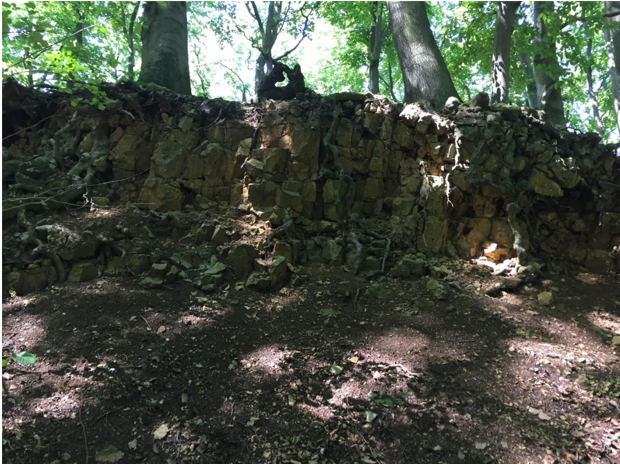
Abbildung 5: Aufschluss des stark geklüfteten, nach Nordosten einfallenden Oberen Muschelkalks an einem Forstweg ca. 500 m südöstlich von Billinghausen
